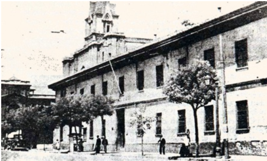
Figura 49. Hospital San Juan de Dios, Santiago.
